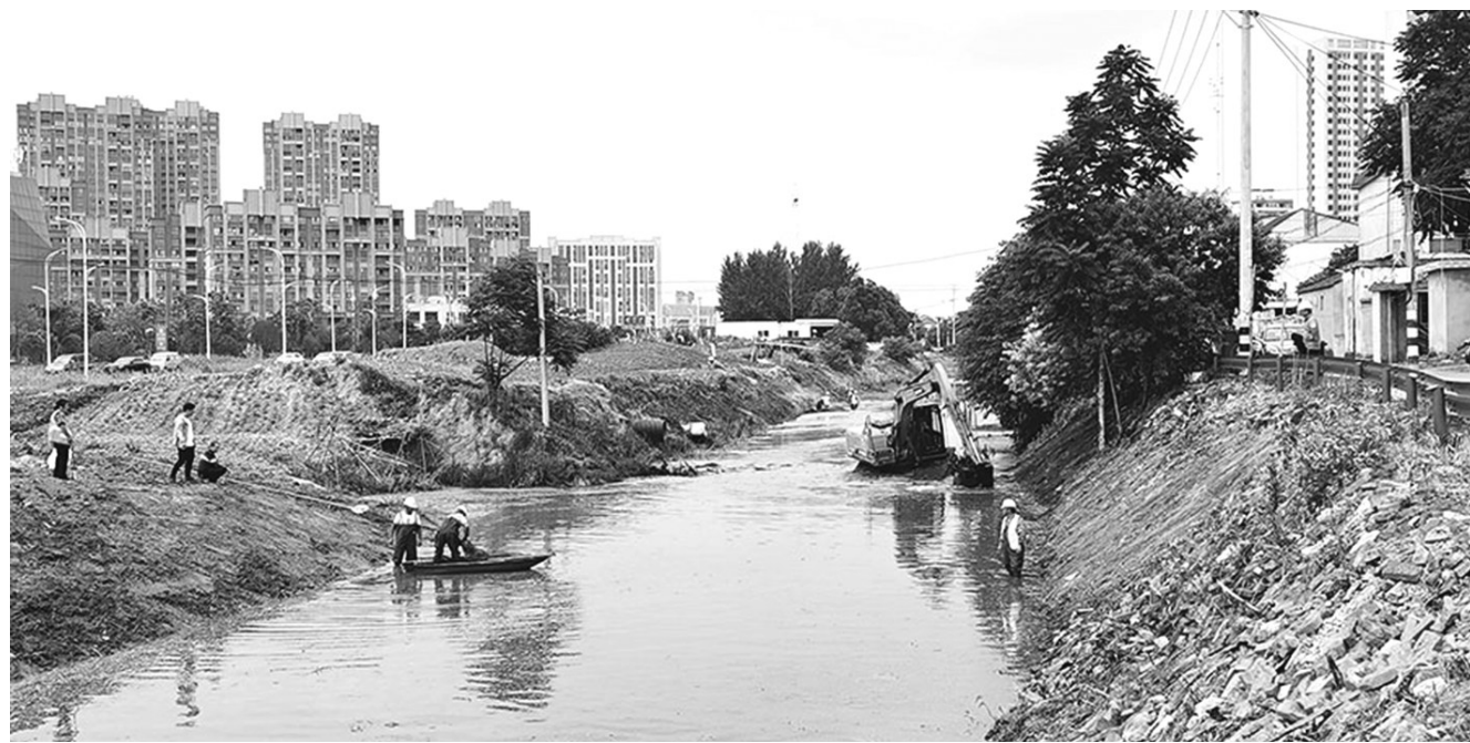
连日来,县住建局组织开展城区河道疏浚排险,进一步提高城区防汛排洪能力,保障河道行洪通畅。(全媒体记者 金锋 通讯员 常创)
